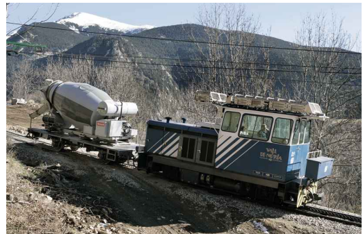
Locomotora DM6 efectuant treballs amb formigonera. Locomotora DM6 efectuando trabajos con hormigonera.
