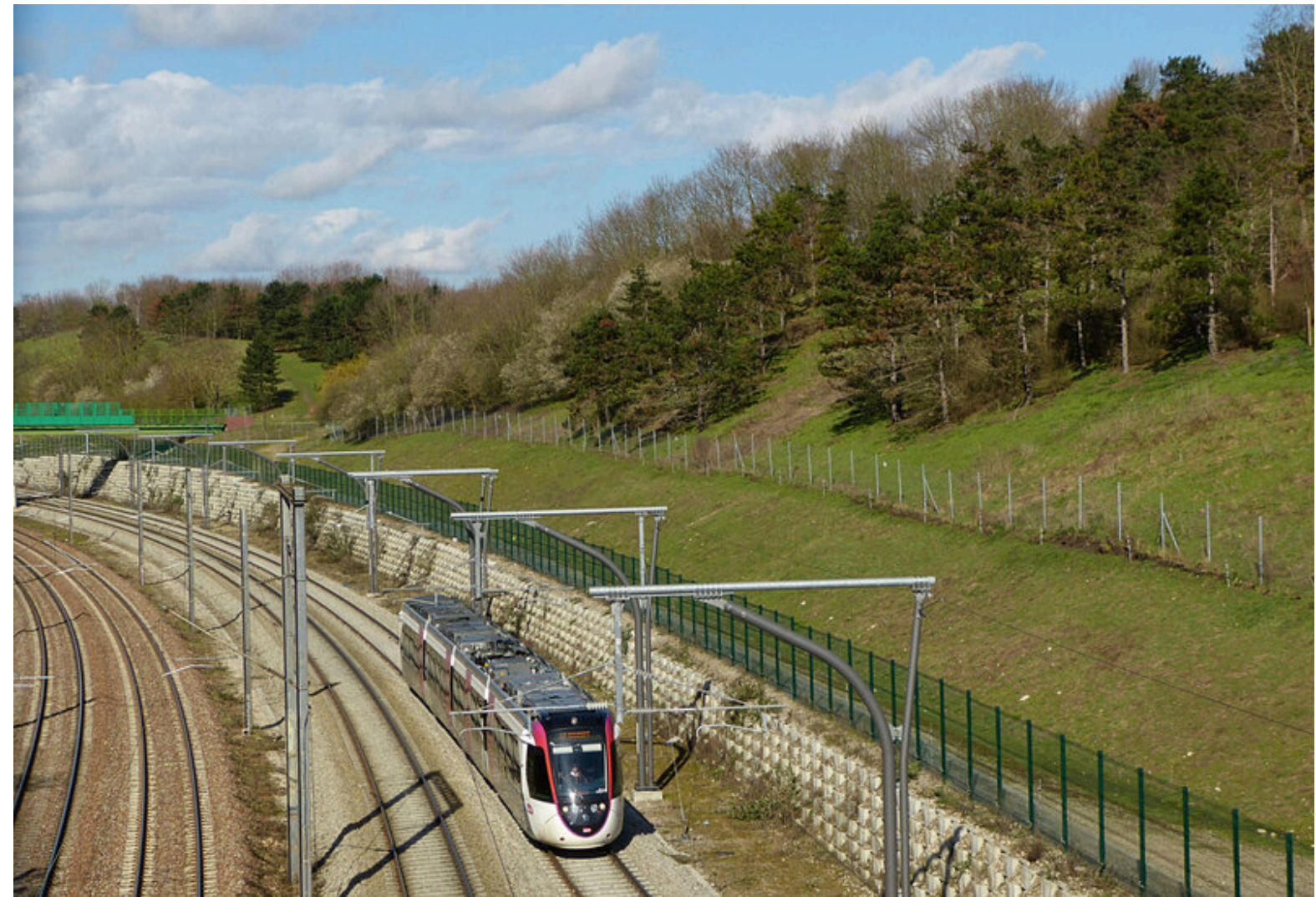
La Courneuve - 11 mars 2018 - Chacun ses voies : à gauche, la Grande Ceinture dédiée au fret et à droite, les deux voies nouvelles au gabarit tram-train pour T11, qui roule tout de même à gauche, alors que T4 également exploité par la SNCF, roule à droite. © transportrail
